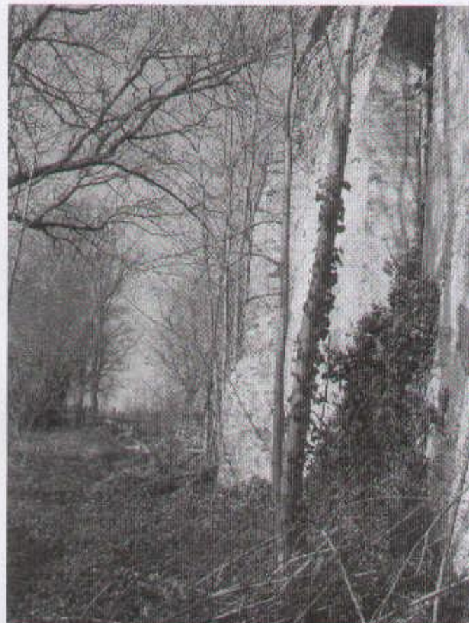
25 zewnętrzny widok ściany szczytowej nawy poprzecznej
