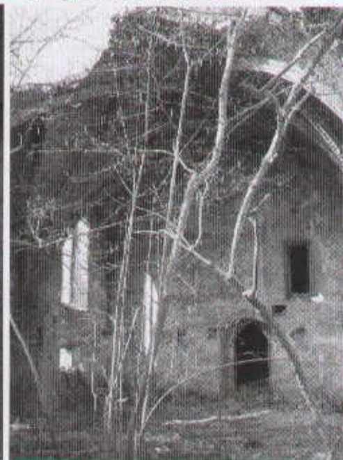
6 widok pozostałości sklepień sieciowych przy ścianie szczytowej z wieżą
