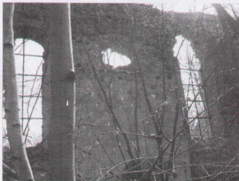
9 widok ściany nawy poprzecznej
