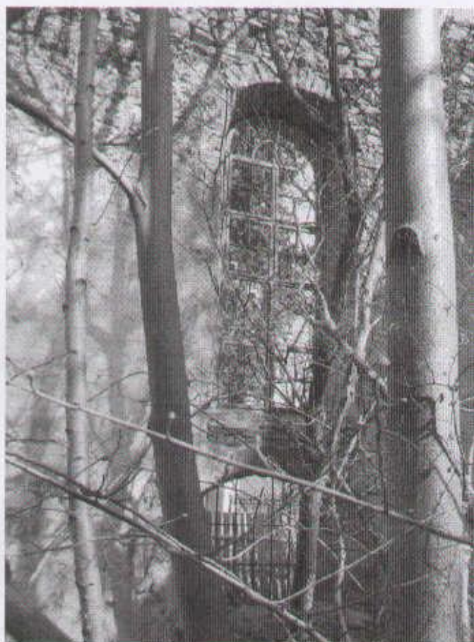
13 okno ściany szczytowej nawy poprzecznej
