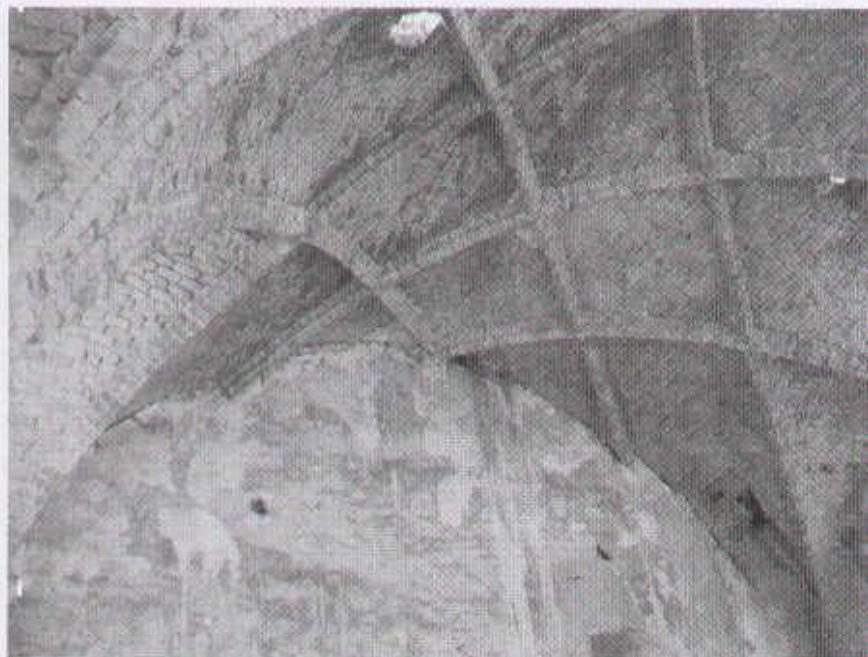
2 widok sklepień sieciowych przy ścianie szczytowej z wieżą
