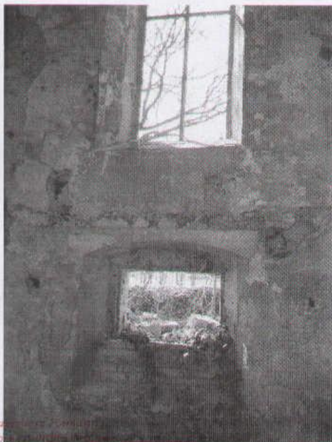
17 otwory okienne pod zachowanymi sklepieniami r. bud. niewiad. 82173 ul. Ogrodowa 6, tel. 722-20-18 59-800 LUBAŃ
