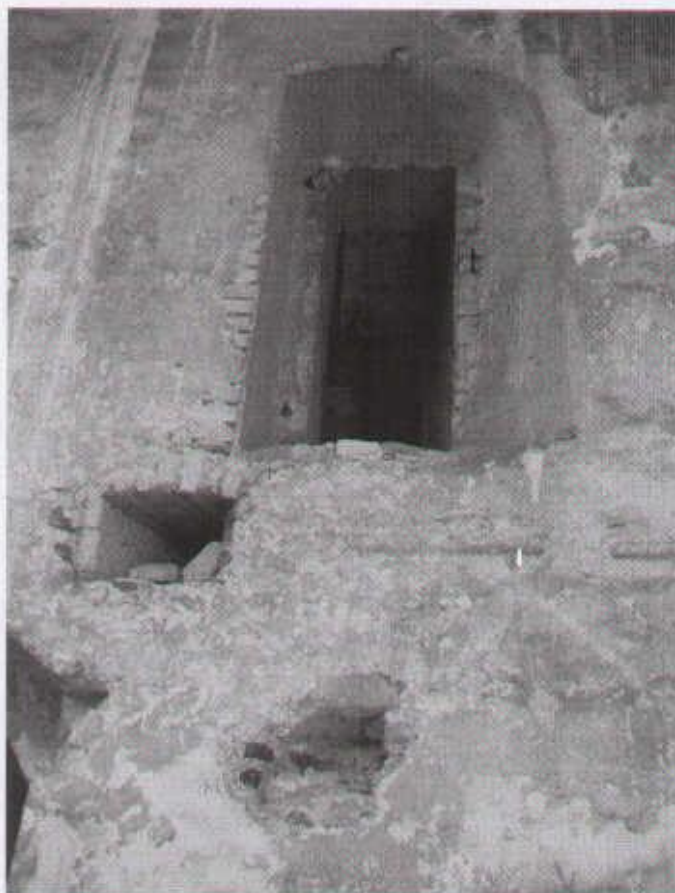
14 ściana szczytowa z wejściami do wieży
