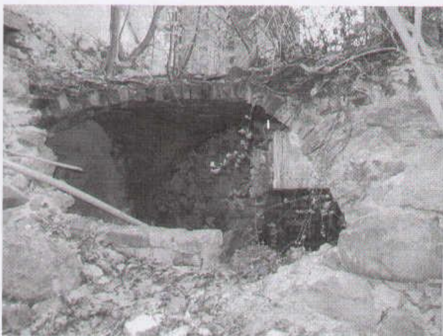
32 widok pozostałości kruchty przed nawą poprzeczną
