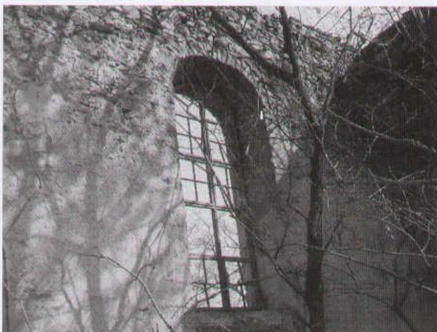
10 pozostałość sklepienia nawy poprzecznej
