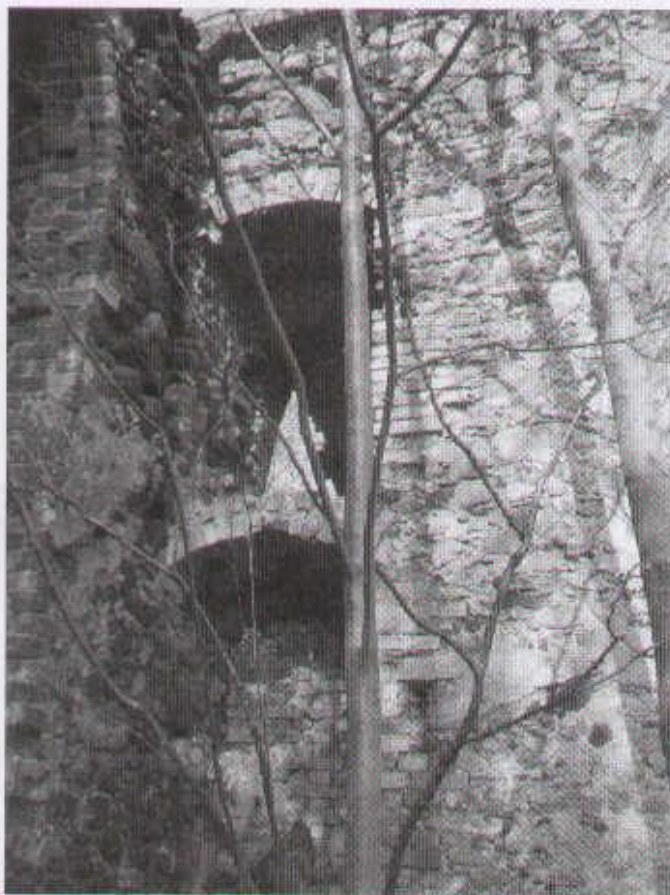
35 wejścia boczne do nawy poprzecznej
