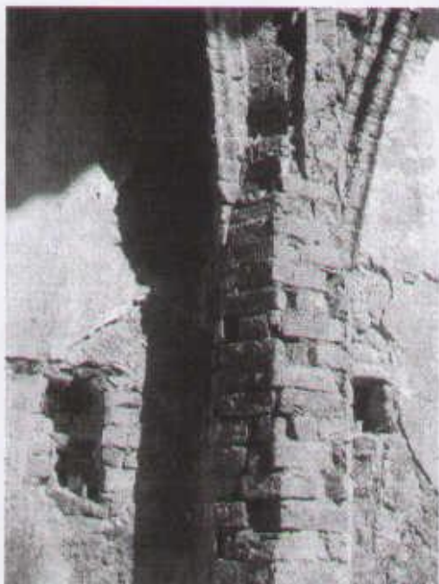
22 filar wieloboczny sklepienia
