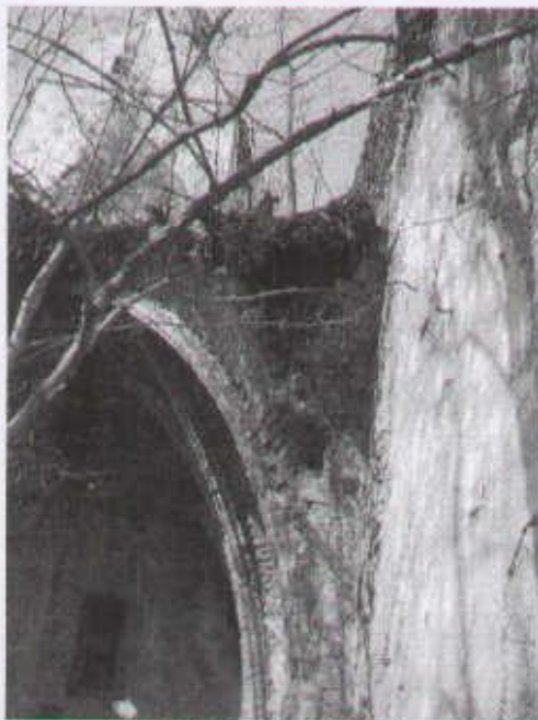
7 zniszczenie sklepień
