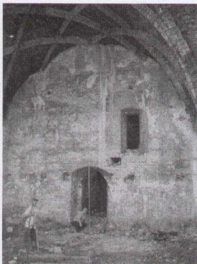
15 ściana szczytowa z wejściami do wieży
