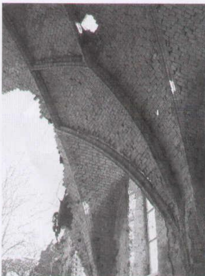
3 zniszczenie sklepień
