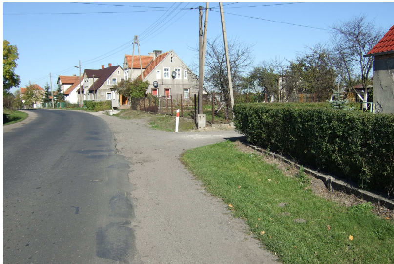
Zdjęcie nr 1. Widok zjazdu z drogi wojewódzkiej na ulicę Lubańską
