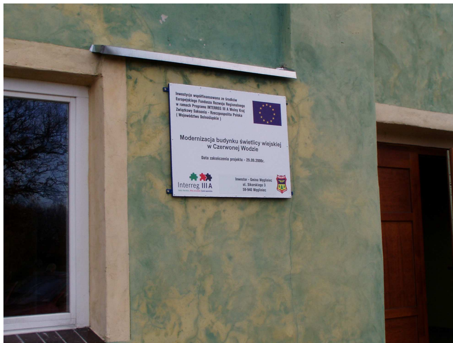
wejście do budynku
