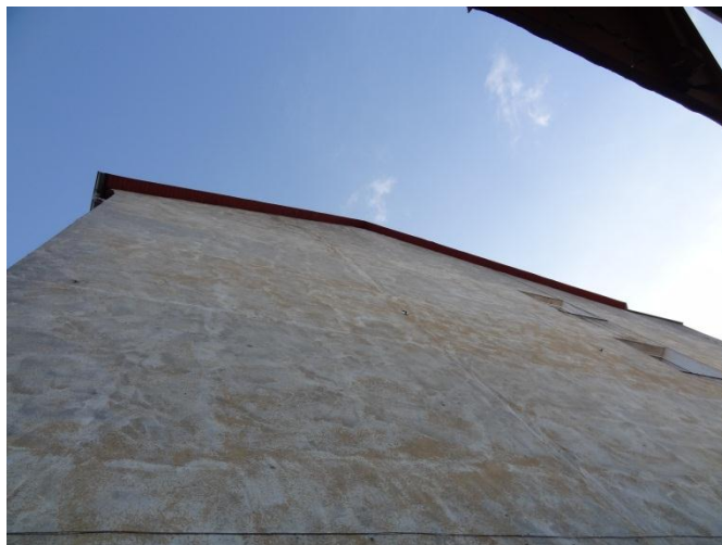
Fot. 2 Elewacja budynku bez widocznych otworów
