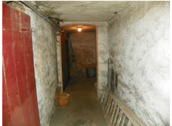
Fot. 2 Piwnica budynku
