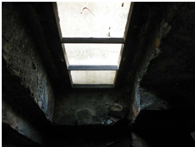
Fot. 4 Okno na strychu-potencjalny wlot nietoperzy
