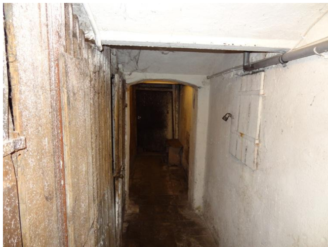
Fot. 2 Piwnica budynku
