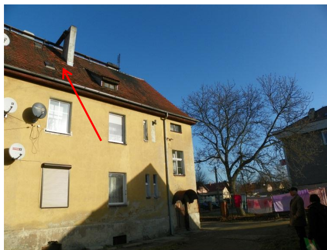
Fot. 4. Okna dachowe - potencjalny wlot nietoperzy na strych
