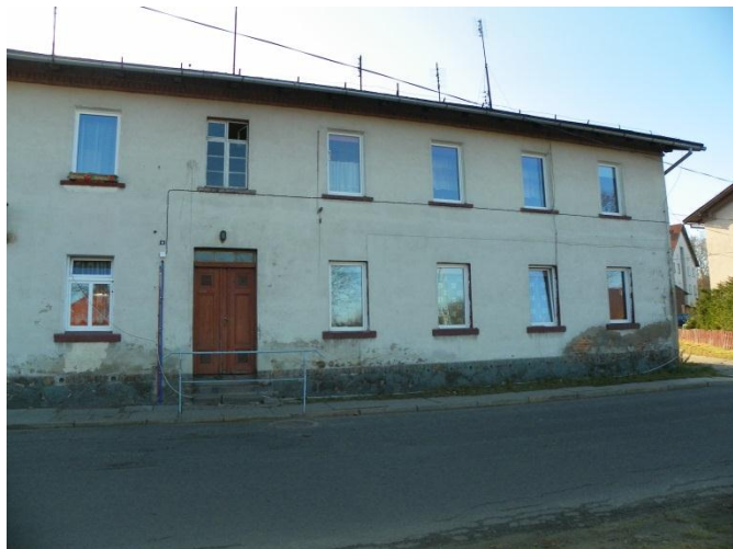
Fot. 1 Budynek przy ul. Kolejowej 4
