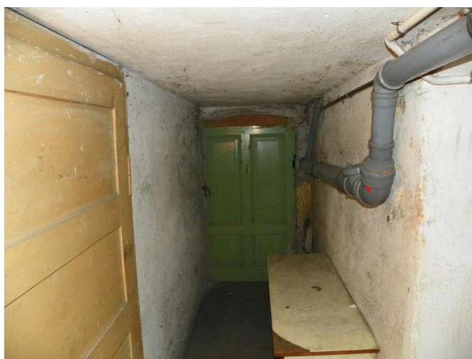
Fot. 2 Piwnica budynku
