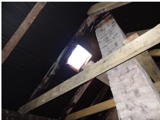
Fot. 4. Dach i zamknięte okno dachowe
