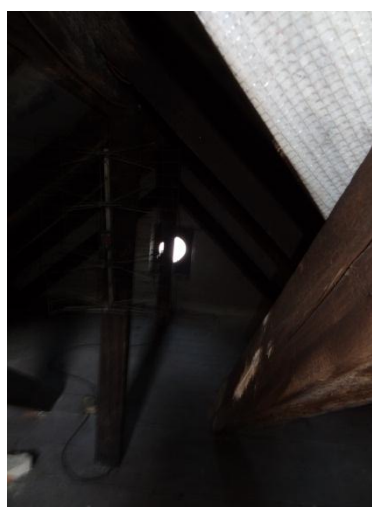
Fot. 4. Otwarte okno - potencjalny wlot nietoperzy na strych
