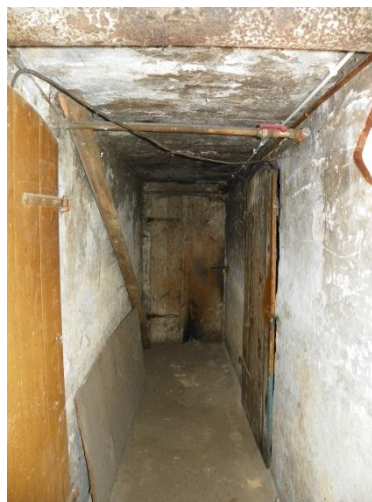
Fot. 2 Piwnica budynku
