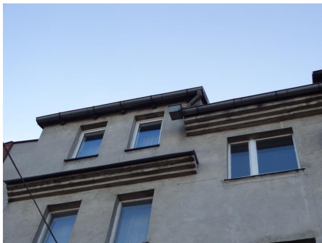
Fot. 4. W elewacji brak otworów, które mogą stanowić kryjówki nietoperzy
