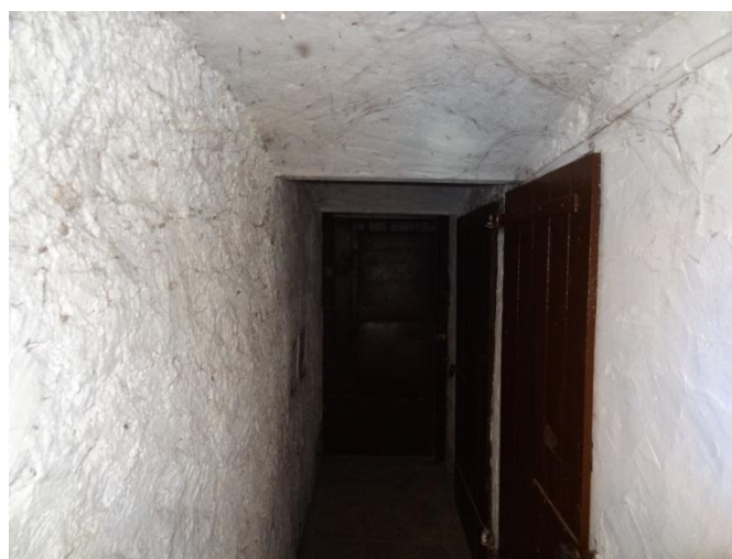
Fot. 2 Piwnica budynku
