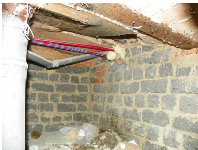
Fot. 3 Wypełniony otwór wokół rury w murze piwnicy
