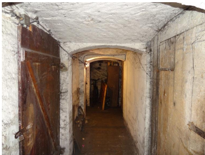
Fot. 2 Piwnica budynku
