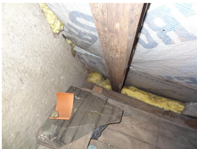
Fot. 3 Uszczelniony dach
