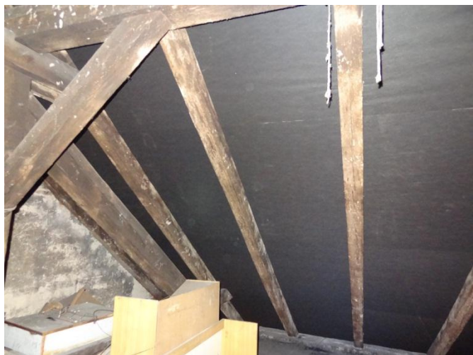
Fot. 3 Uszczelniony dach
