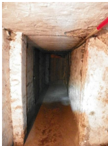
Fot. 2 Piwnica budynku
