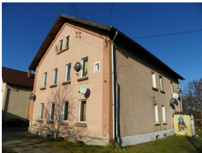
Fot. 1 Budynek przy ul. Kolejowej 10
