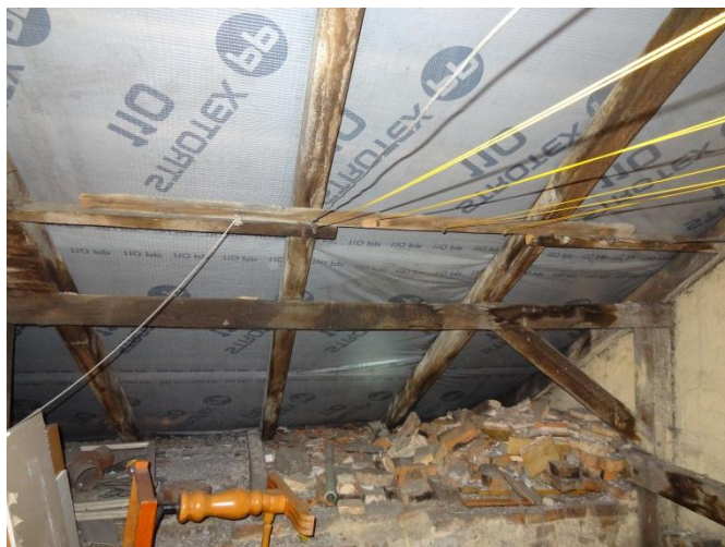
Fot. 4. Uszczelnienie dachu
