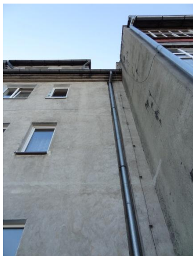
Fot. 3 W elewacji brak otworów, które mogą stanowić kryjówki nietoperzy
