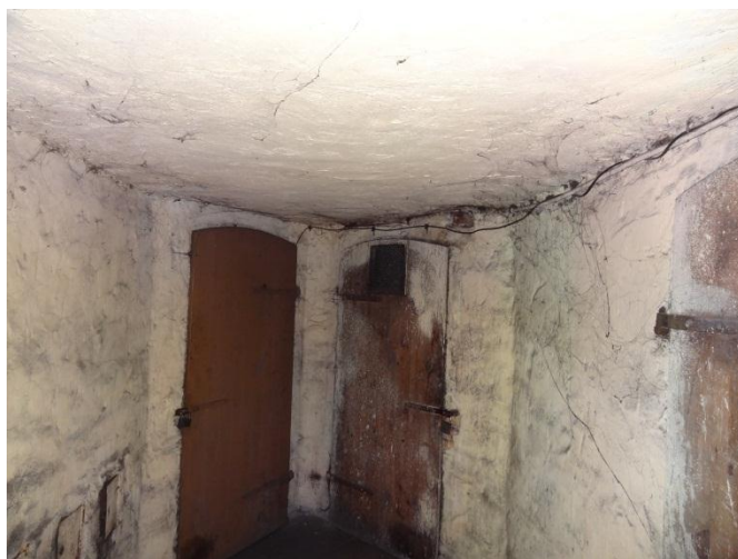
Fot. 2 Piwnica budynku
