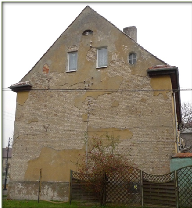
Elewacja budynku przy ul. Sikorskiego 42.
